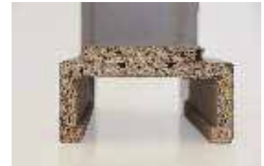
Obložková zárubeň konstrukce SEPOS v řezu
