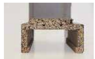
Obložková zárubeň Vertikal konstrukce SEPOS v řezu
